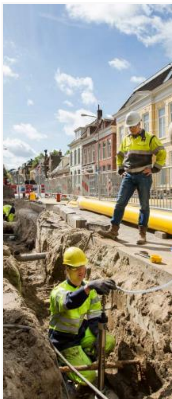
Figuur 4.7: Elektriciteitsnet werkzaamheden in de straat. 10
