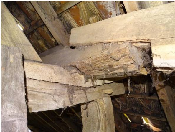
Afb. 4.11 Verbinding flieringen
