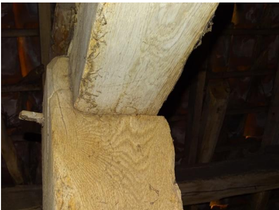
Afb. 4.5 Verbinding ankerbalk met gebintstijl (t.p.v. overstek)
