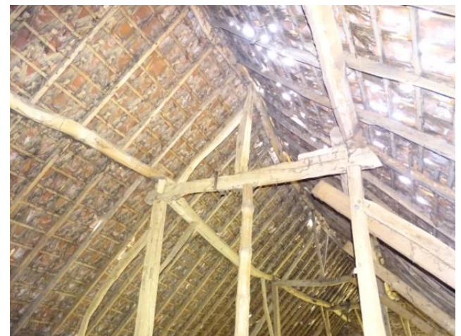
Afb. 4.22 Fliering tussen spant 1 en eindgevel
