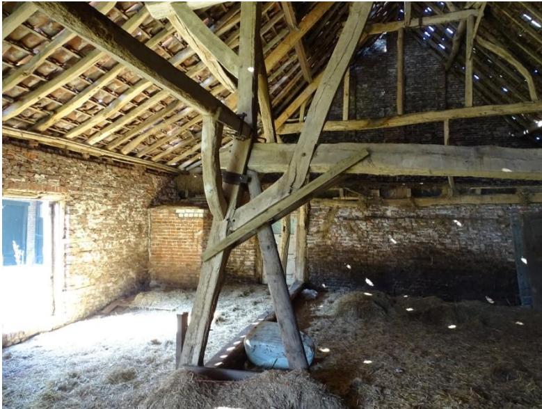
Afb. 4.34 Herstellingen en ondersteuning verbindingen gebintstijl
