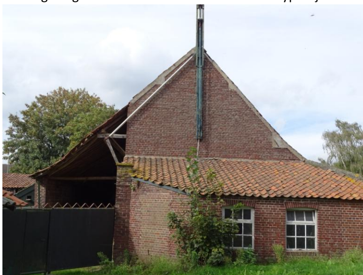
Afb. 2.11 Gemetselde kopgevel met inrij-opening Vlaamse schuur Bruggerhof
