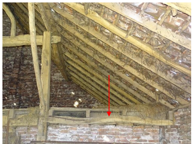
Afb. 4.29 Koppelbalk spant 1 met buitenmuur
