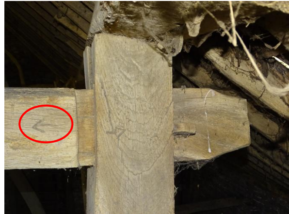
Afb. 4.42 Telmerken op beide delen ankerbalk
