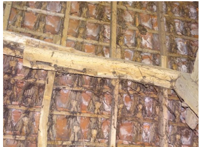
Afb. 4.20 Koppeling flieringen tussen spant 1 en 2
