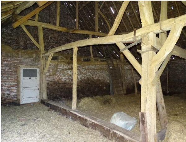
Afb. 4.14 Koppeling spant 1 en 2
