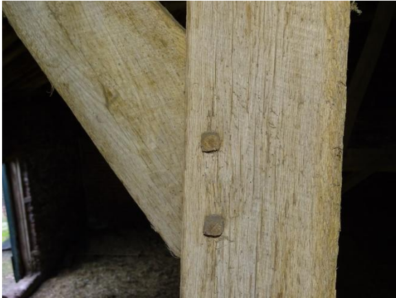
Afb. 4.7 Schuine verbinding ankerbalkschoor met ankerbalkgebintstijl
