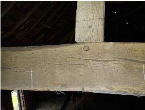
Afb. 4.8 Rechte verbinding nokstijl met dekbalk
