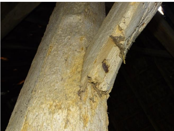
Afb. 4.9 Verbinding jukflieringschoor met dekbalkgebintstijl
