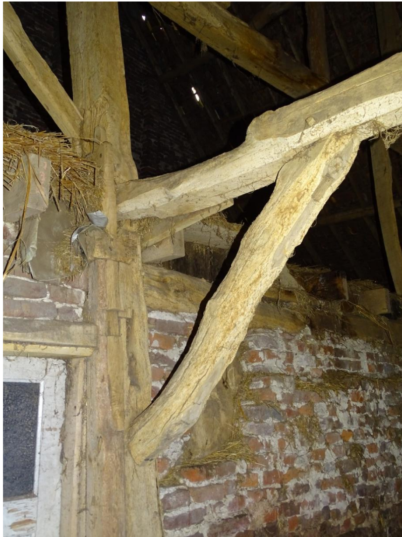
Afb. 4.12 Ruw, deels gekantrecht eikenhouten onderdelen met wisselende afmetingen
