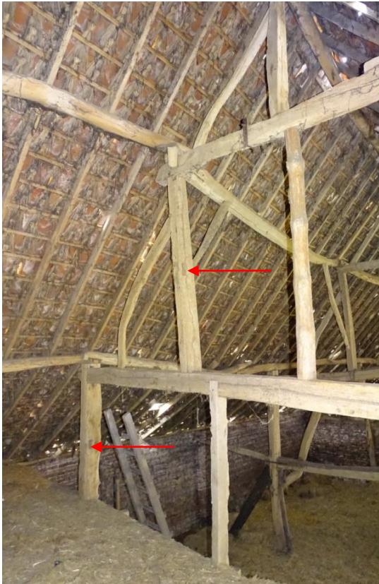
Afb. 4.27 Sporen van horizontale regels
