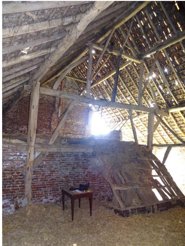
Afb. 4.46 Spant 3 is het meest authentiek gebleven
