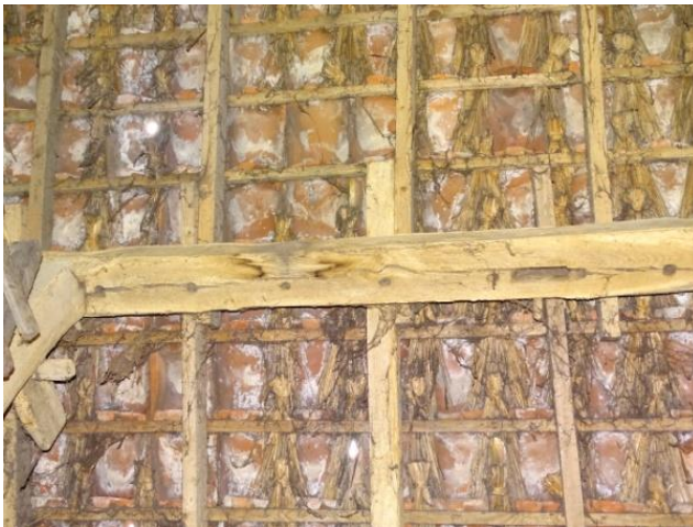
Afb. 4.19 Fliering aansluitend aan spant 1
