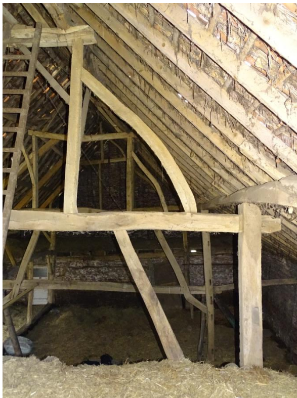
Afb. 4.39 spoor van verbinding flieringschoor
