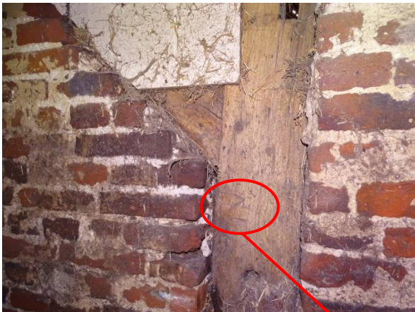
Afb. 4.43 Telmerk op achterste stijl aan stalzijde
