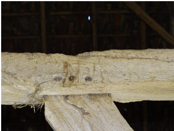
Afb. 3.11 Gesloten pen en gatverbinding met toognagels
