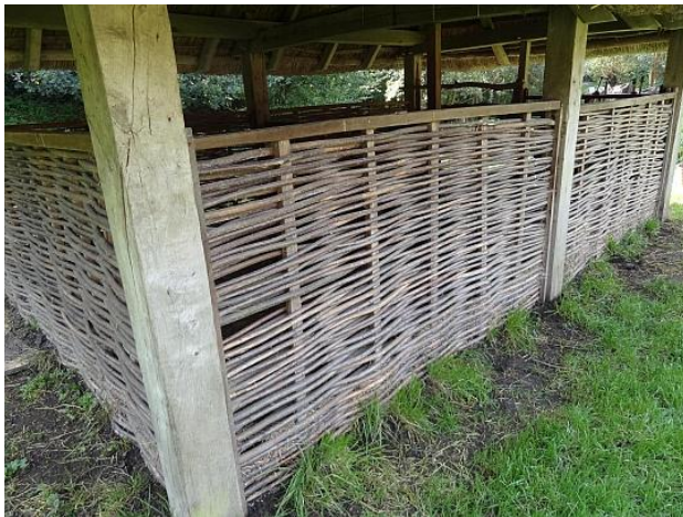
Afb. 3.4 Vlechtwerk met eiken staken en wilgentenen (14)
