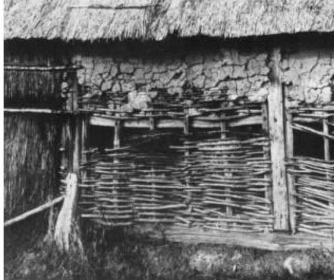
Afb. 2.10 Detail buitenwand van de schuur in Gilze-Rijen, afgewerkt met een vlechtwerk van staken en wilgentenen en afgesmeerd met stroleem. (In 1923 gefotografeerd door Klaas Uilkema) (8)
