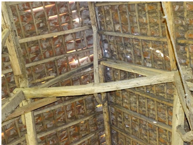
Afb. 4.32 Schaarspantje met schoren in nok
