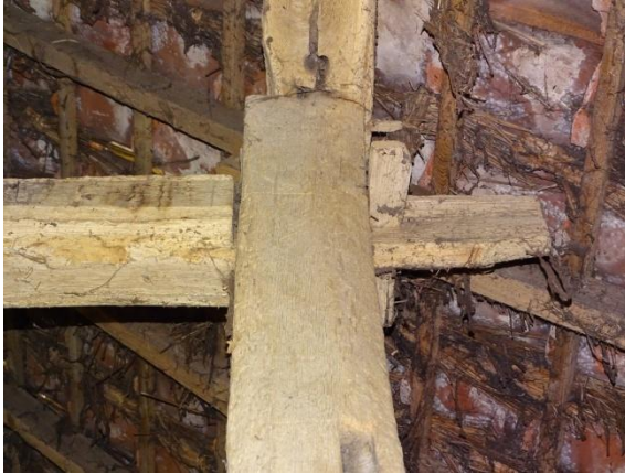
Afb. 4.4 Verbinding ankerbalk met gebintstijl
