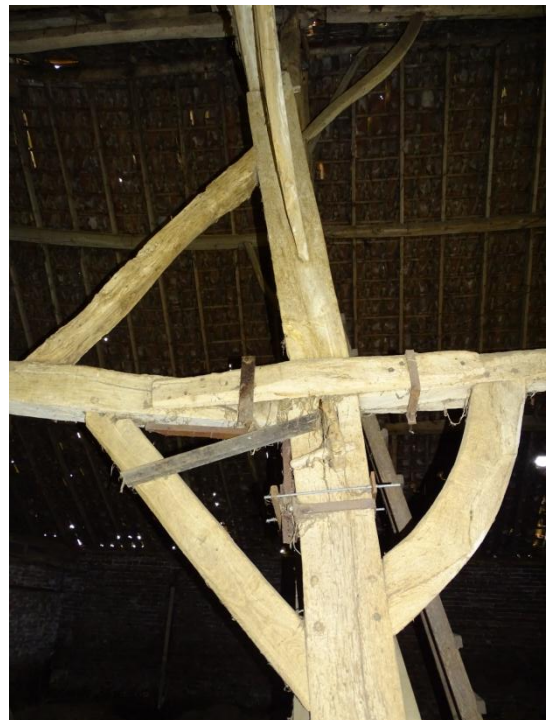
Afb. 4.33 Herstellingen verbindingen gebintstijl
