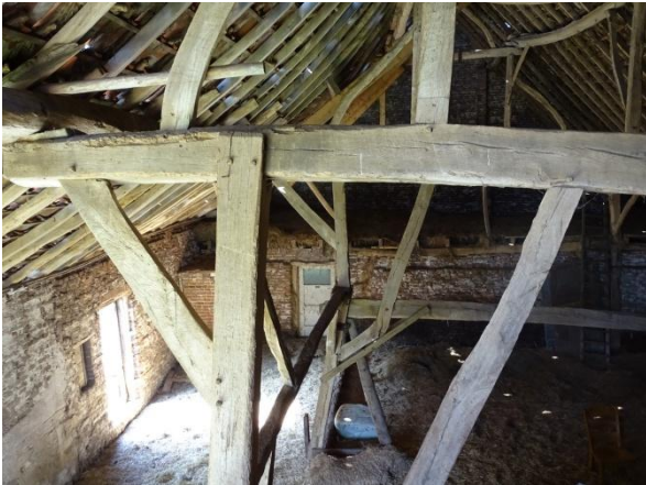
Afb. 4.41 Oorspronkelijke verbindingen
