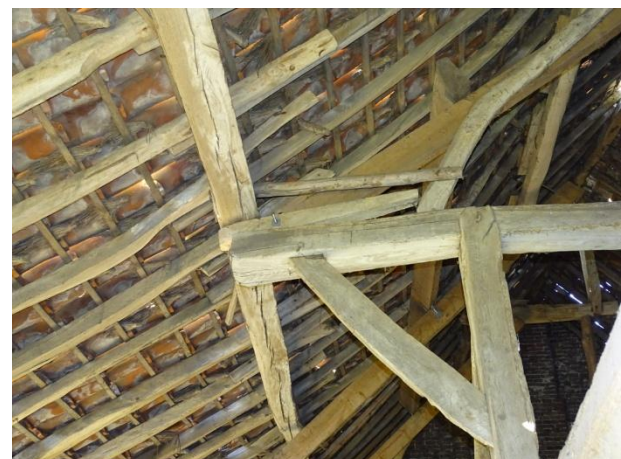
Afb. 4.37 Herstelling oplegging fliering op ankerbalk
