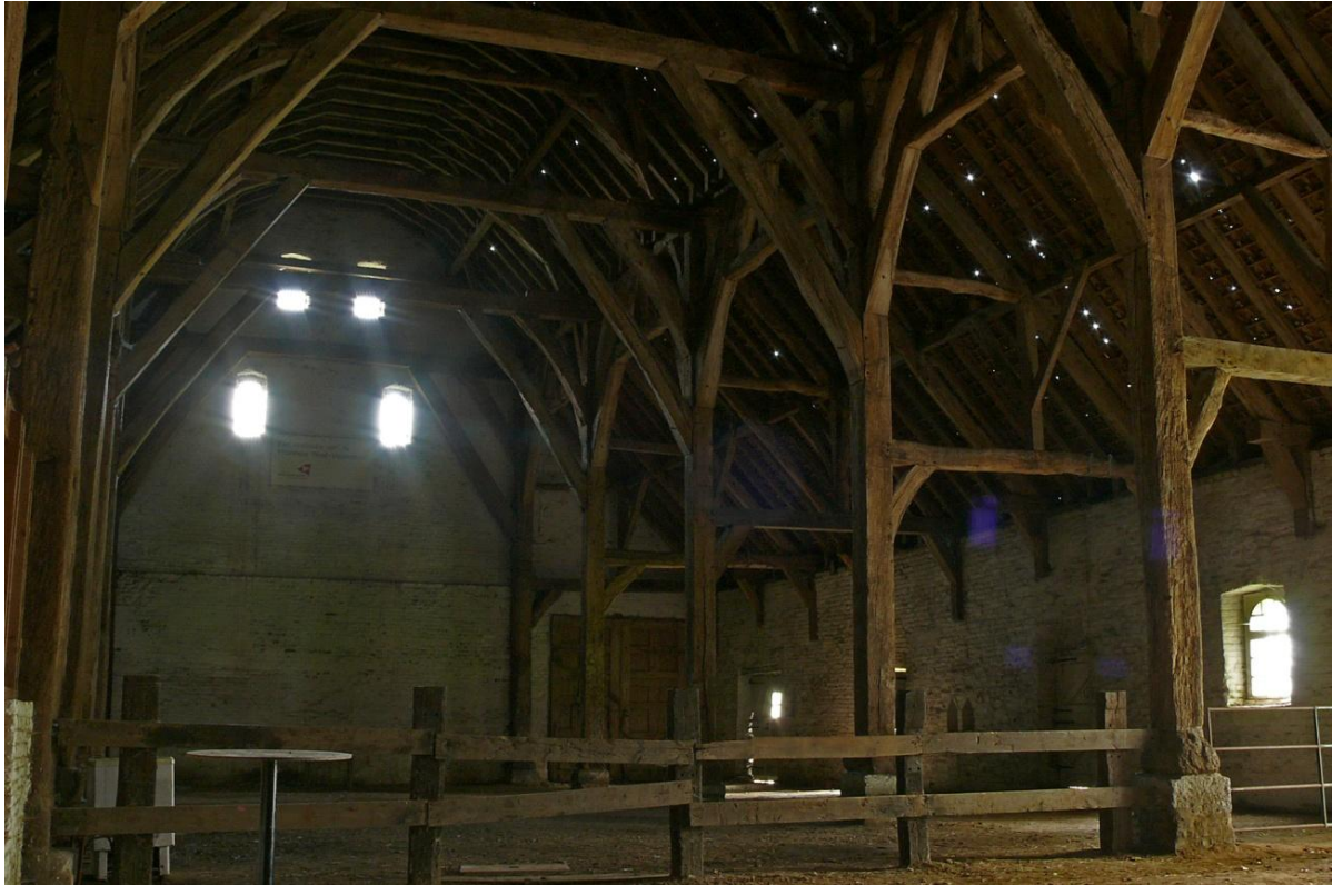
Afb. 2.2 Spantconstructie van de abdijshuur in Ter Doest (internetsite:Wikimedia Commons)
