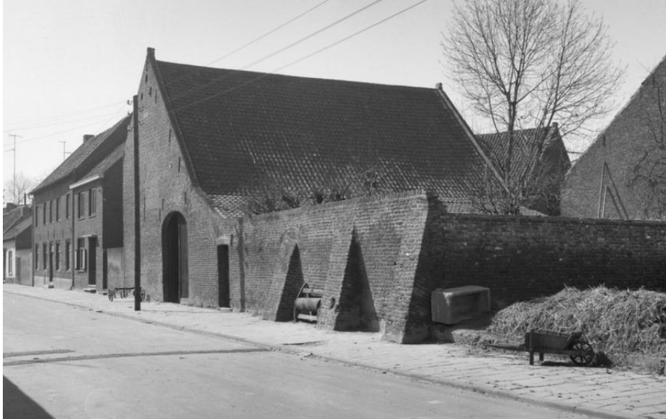
Afb. 5.3 Situatie schuur in de jaren '70
