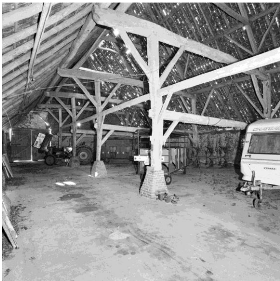
Afb. 5.6 Overzicht spantconstructies schuur Ottersum (4)
