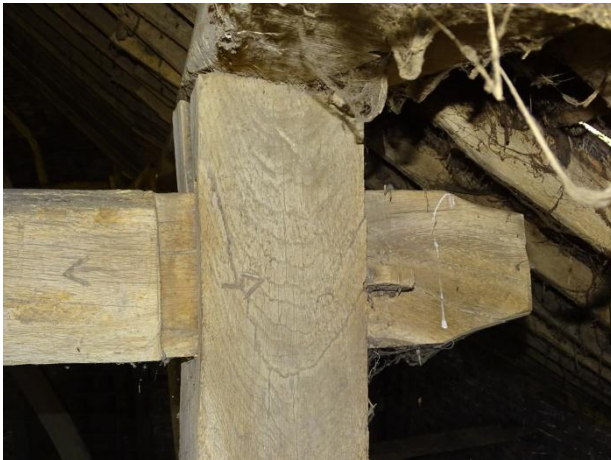
Afb. 3.9 Doorstekende pen en gatverbinding met wiggen
