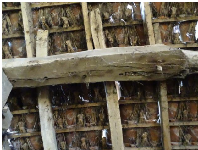
Afb. 4.21 Overstekende fliering bij spant 3
