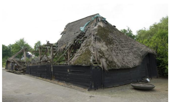
Afb. 3.6 Vlaamse schuur in Breda met gevel van rabatdelen (14)
