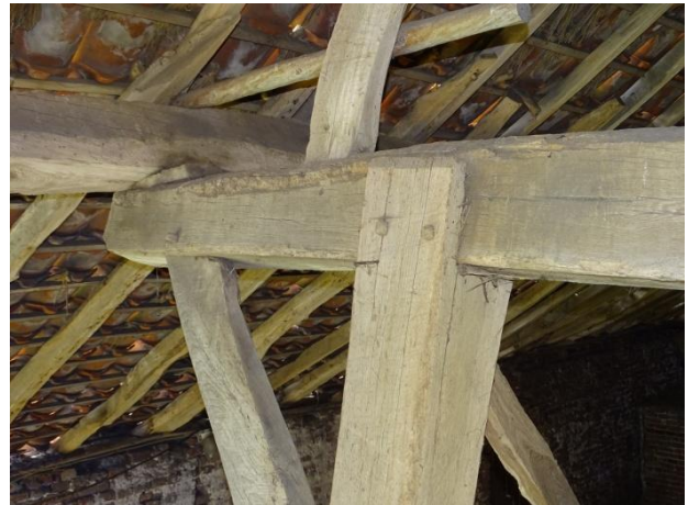
Afb. 3.10 Verbinding met ingelaten balk
