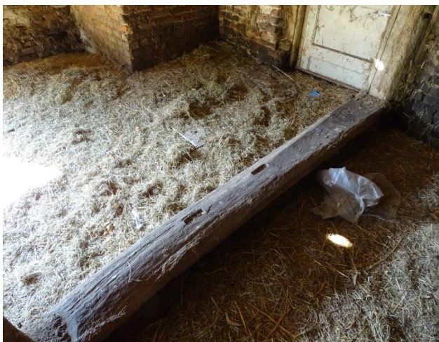
Afb. 4.17 Sporen in balken op vloerniveau
