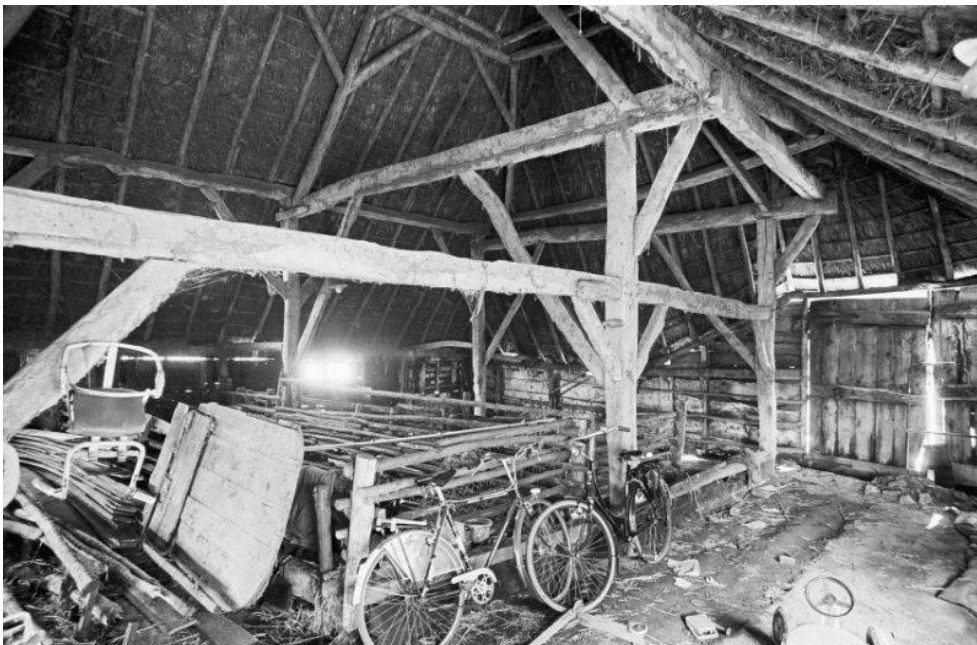
Afb 2.12 en 2.13 Zeer fraai voorbeeld van een kleine Vlaamse schuur uit 1686 in het Brabantse Chaam (buiten- en binnenzijde) (8)
