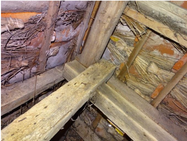
Afb. 4.10 Nokverbinding schaarspant
