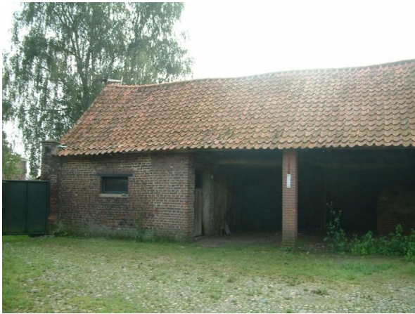
Afb. 3.81 Rechterzijde bouwdeel D
