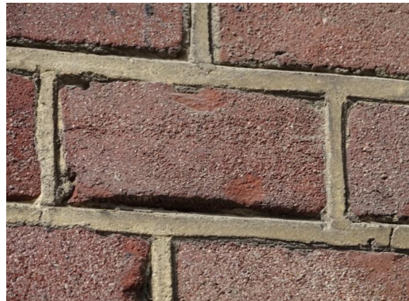
Afb. 3.9 Gesneden voegwerk voorgevel
