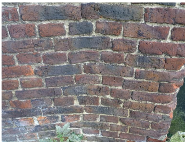
Afb. 3.35 Gebogen metselwerk achtergevel paardenstal
