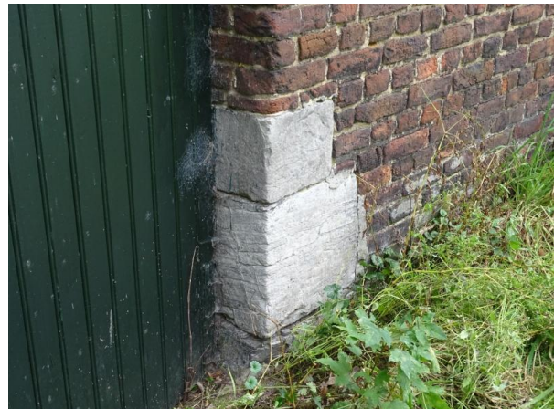
Afb. 3.23 Hardstenen blokken op hoek bouwdeel A
