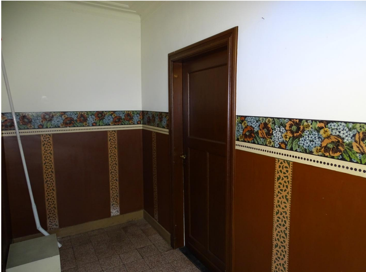
Afb. 3.152 Met olieverf geschilderde lambrisering gang
