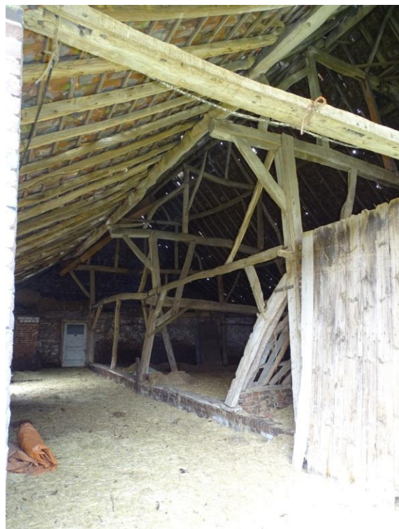
Afb. 3.121 Overzicht vakwerkconstructie grote schuur
