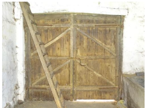
Afb. 3.192 Binnenzijde dubbele poort stal
