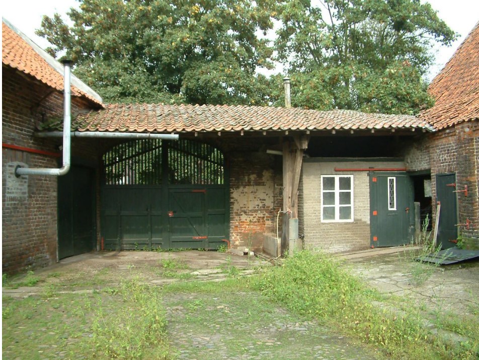
Afb. 3.68 Overkapping bouwdeel B
