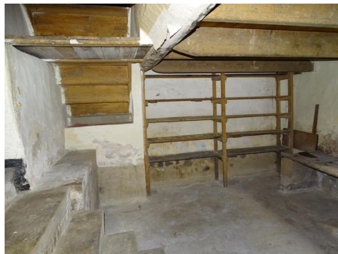
Afb. 3.171 Kelder met onderzijde trap naar zolder
