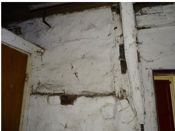
Afb. 3.191 Sporen vakwerkconstructie in tussenmuur
