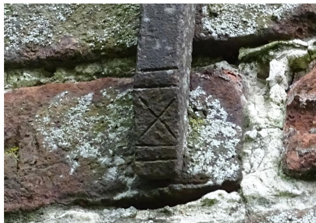
Afb. 3.28 Versiering muuranker
