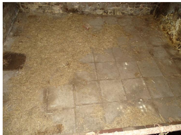
Afb. 3.98 Vloer varkenstal bouwdeel C
