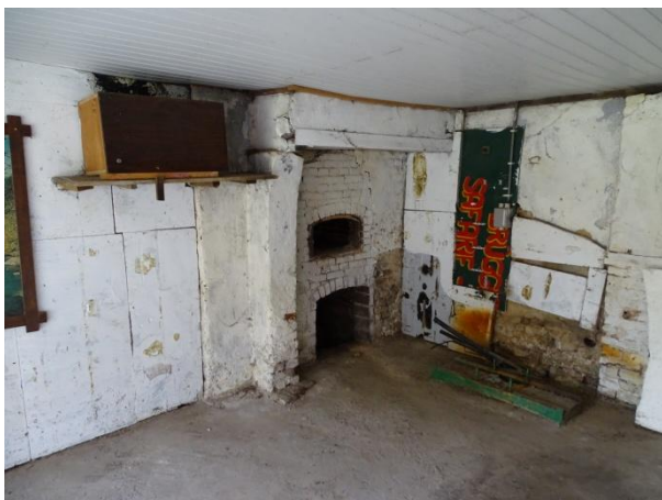
Afb. 3.97 Vloer garage bouwdeel D
