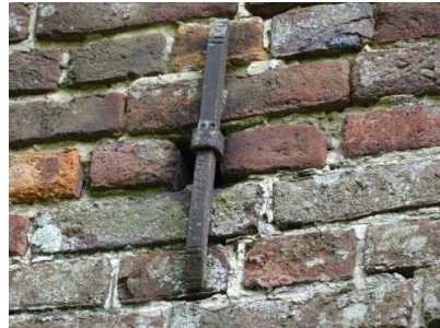
Afb. 3.26 Muuranker bouwdeel A
