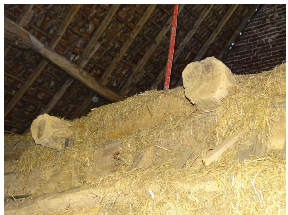
Afb. 3.103 Balk vloer boven ruimte C.0.14
