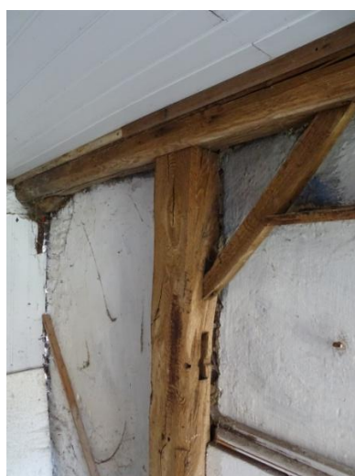
Afb. 3.216 Sporen vakwerkconstructie
