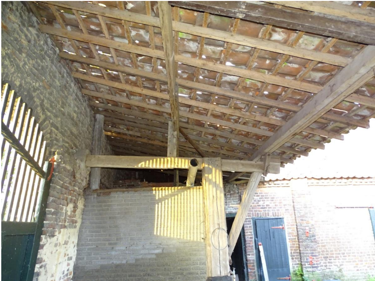
Afb. 3.116 Onderzijde overkapping bouwdeel B
