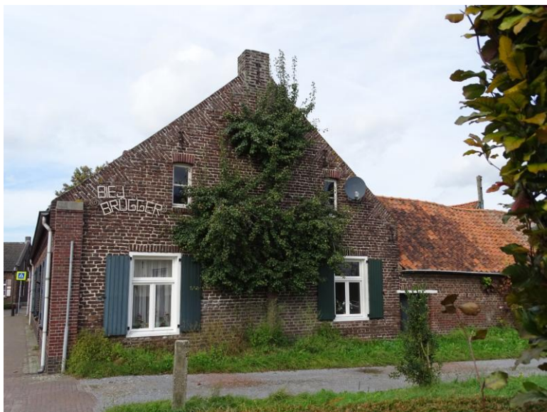
Afb. 3.39 Aanzicht rechter zijgevel woning
