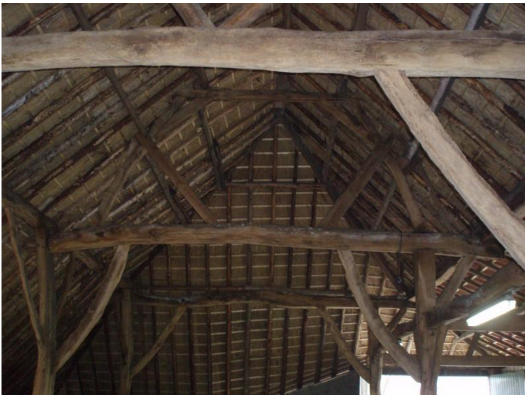
Afb. 5.1 Voorbeeld van een authentieke constructie van een Vlaamse schuur in buurtschap Vroenhout in Roosendaal
