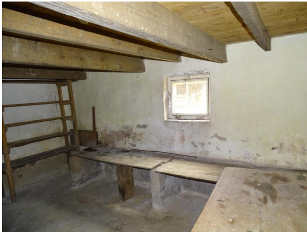
Afb. 3.169 Kelder met buitenraam
