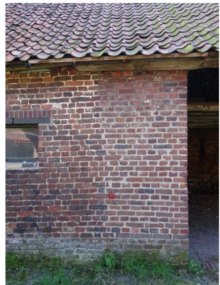
Afb. 3.84 Overgang naar recent metselwerk
