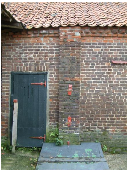
Afb. 3.73 Fragment metselwerk linkerzijde grote schuur
