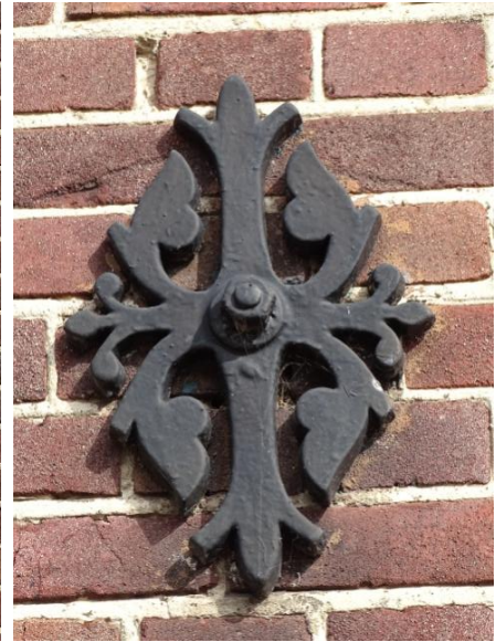
Afb. 3.12 Gietijzeren muuranker
