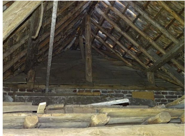
Afb. 3.149 Aansluiting dakconstructie op kap woning
