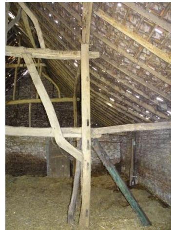
Afb. 3.128 Rechter verbinding spant 2
