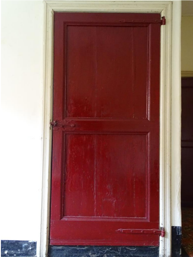
Afb. 3.175 Binnendeur naar zolder en opkamer
