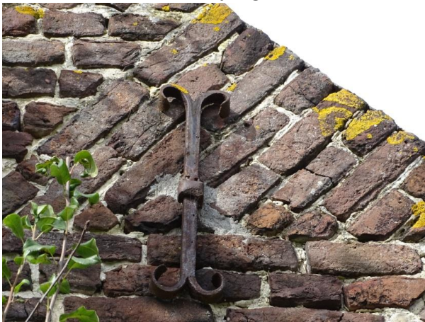
Afb. 3.40 Muuranker rechter zijgevel woning
