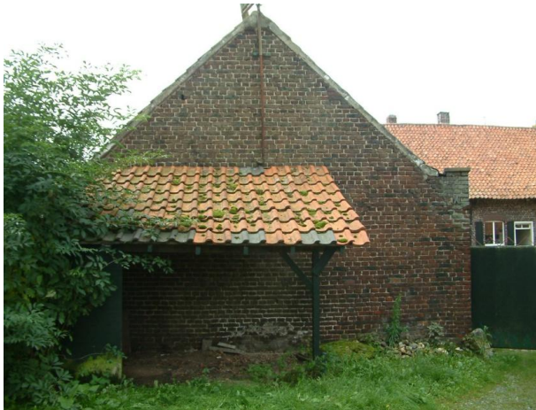
Afb. 3.31 Overkapping aan achterzijde paardenstal
