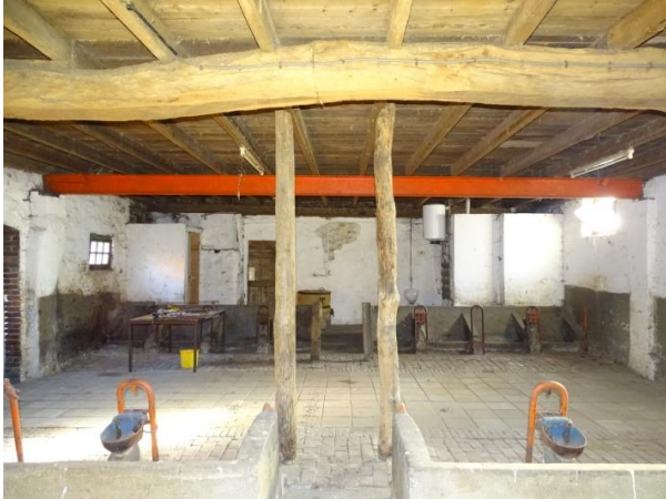
Afb. 3.189 Overzicht stal bouwdeel A
