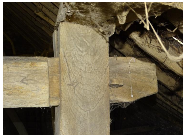
Afb. 3.132 Verbinding ankerbalk met jukbeem spant 2
