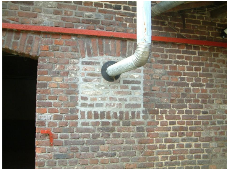
Afb. 3.64 Sporen voormalig stalvenster rechts
