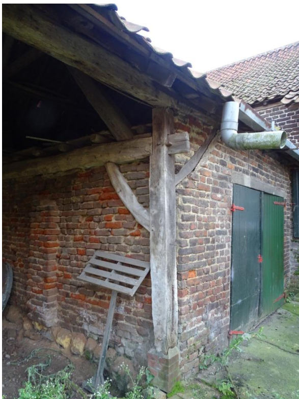
Afb. 3.144 Vakwerkconstructie in tussenmuur bouwdeel A
