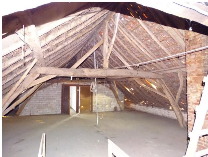
Afb. 3.105 Spant kapconstructie woning
