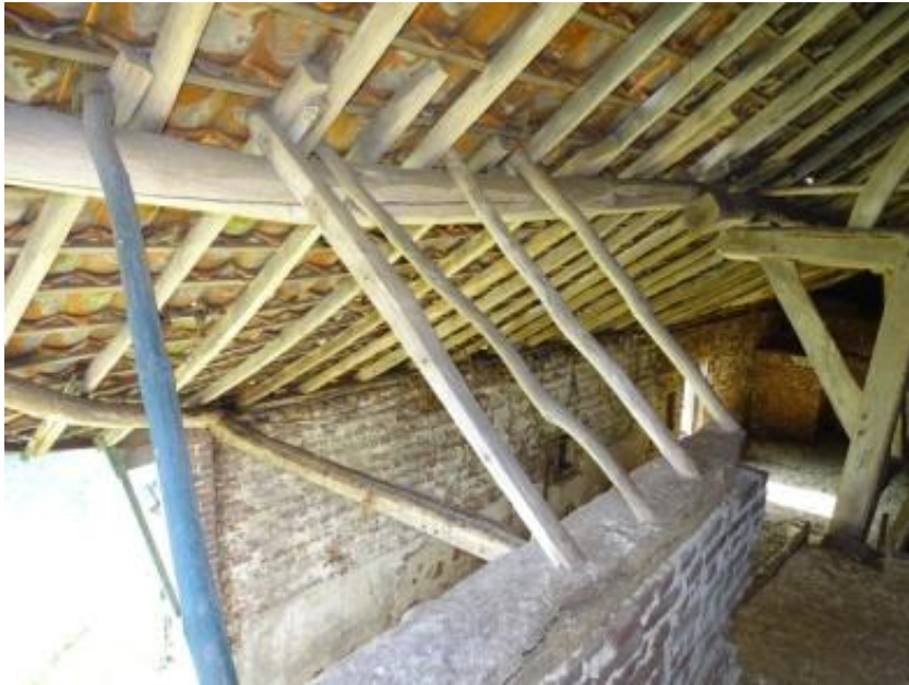
Afb. 3.143 Dakconstructie boven invaart schuur
