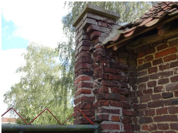
Afb. 3.33 sporen in metselwerk rechter penant
