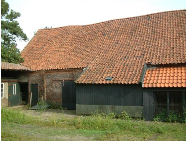
Afb. 3.71 Linkerzijde grote schuur
