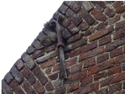
Afb. 3.25 Muuranker bouwdeel A
