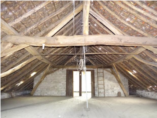
Afb. 3.184 Zolder boven woning
