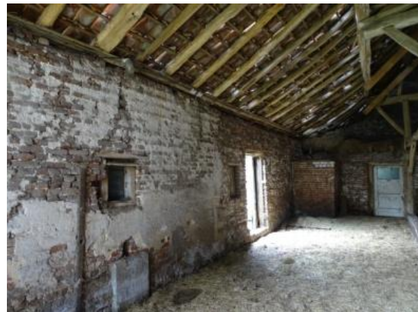
Afb. 3.142 Dakconstructie boven de 'deel' van de schuur
