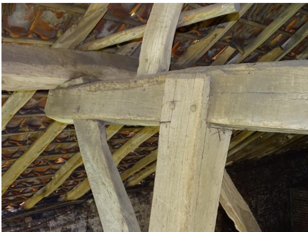
Afb. 3.131 Detail doorstekende ankerbalk spant 2
