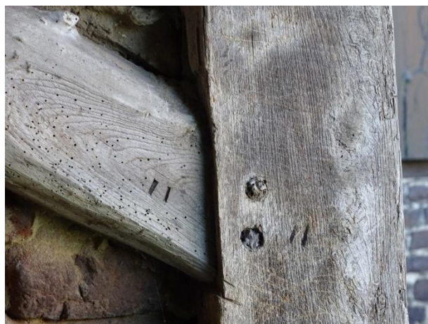
Afb. 3.145 Telmerken in vakwerkconstructie
