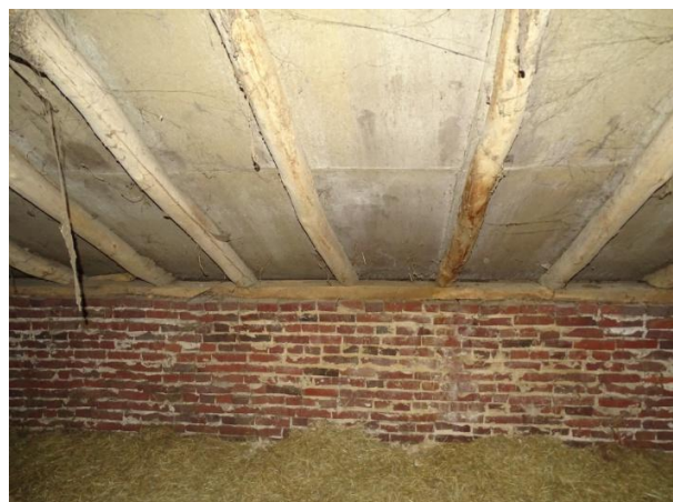
Afb. 3.195 Aansluiting kap op buitengevel
