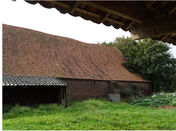
Afb. 3.30 Rechterzijde grote schuur
