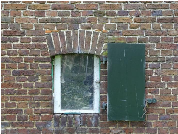
Afb. 3.20 Venster zijgevel bouwdeel C
