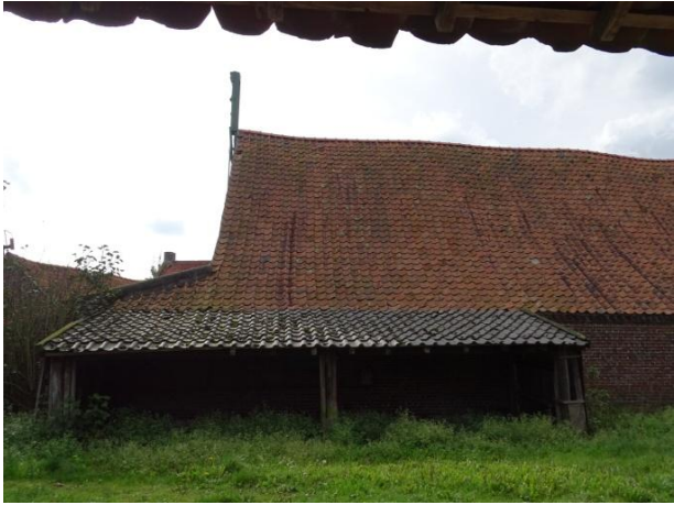
Afb. 3.29 Linkerzijde grote schuur
