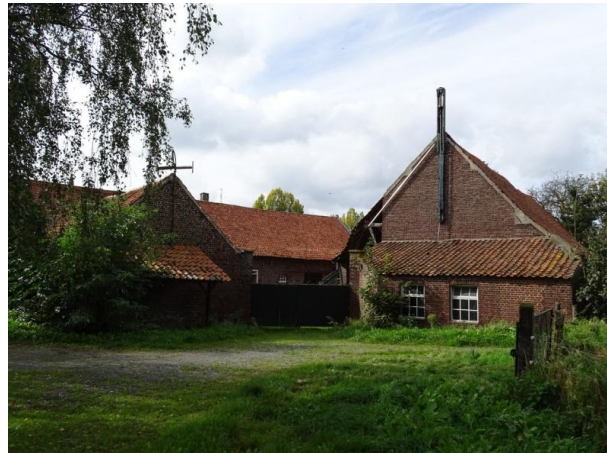
Afb. 3.6 Aanzicht achterzijde bouwdeel D en zijgevel bouwdeel C
