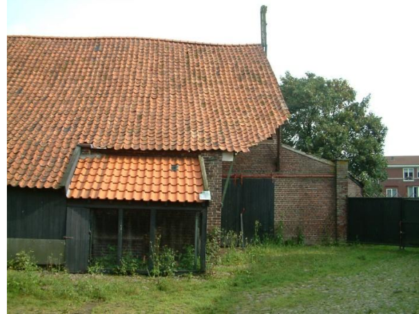
Afb. 3.72 Rechterzijde grote schuur
