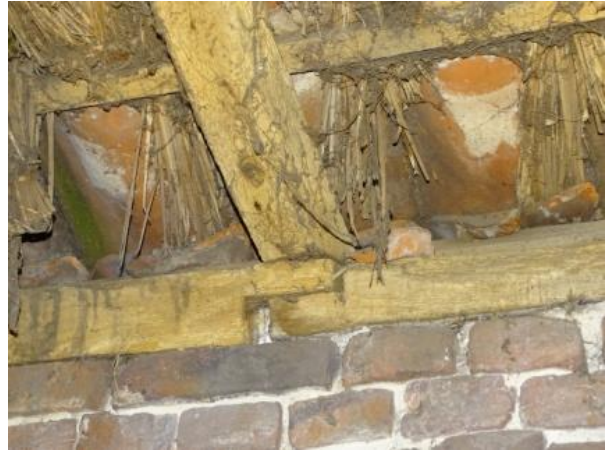
Afb. 3.139 verbinding muurplaten
