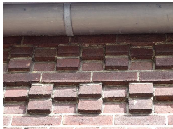
Afb.3.10 Muizentanden aan bovenzijde voorgevel bouwdeel A
