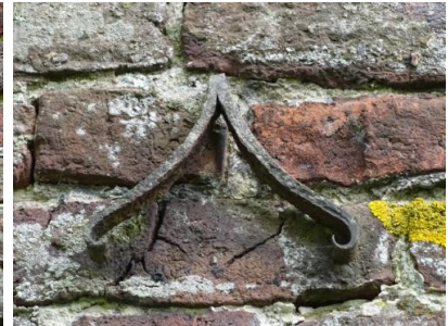
Afb. 3.27 Muuranker bouwdeel A
