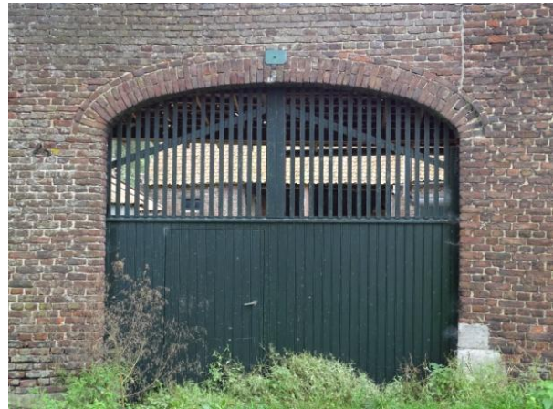
Afb. 3.21 Poort bouwdeel B
