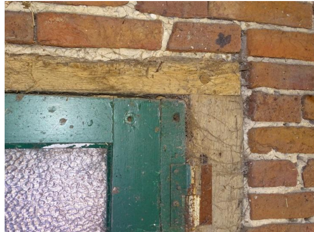
Afb. 3.199 Oud binnendeurkozijn met nieuwere deur
