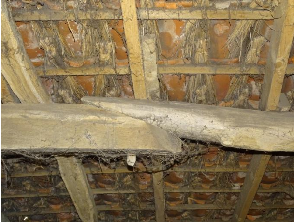
Afb. 3.138 Verbinding flieringen
