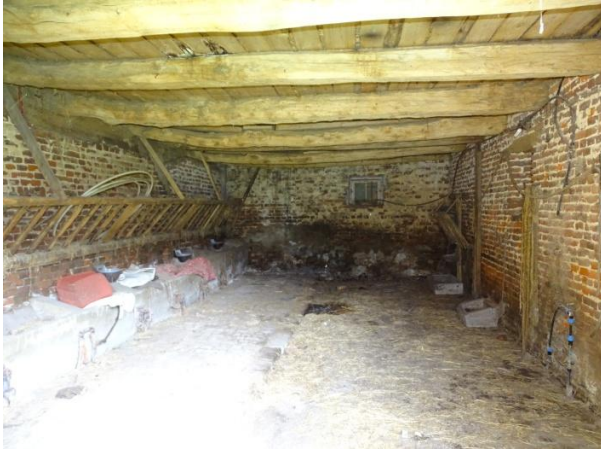
Afb. 3.205 Balklaag zoldervloer koeienstal
