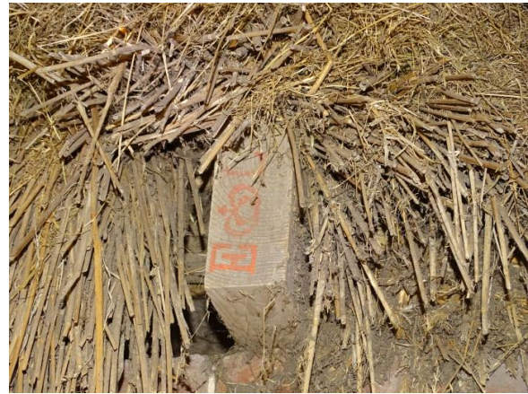
Afb. 3.101 Balk vloer boven ruimte C.0.12
