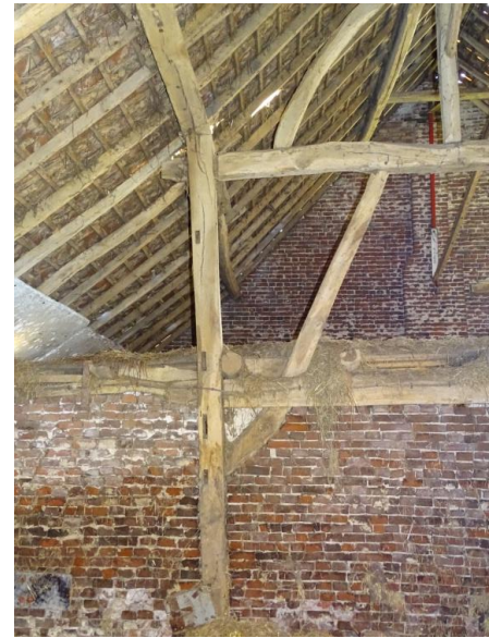
Afb. 3.133 Ingemetseld deel spant 3
