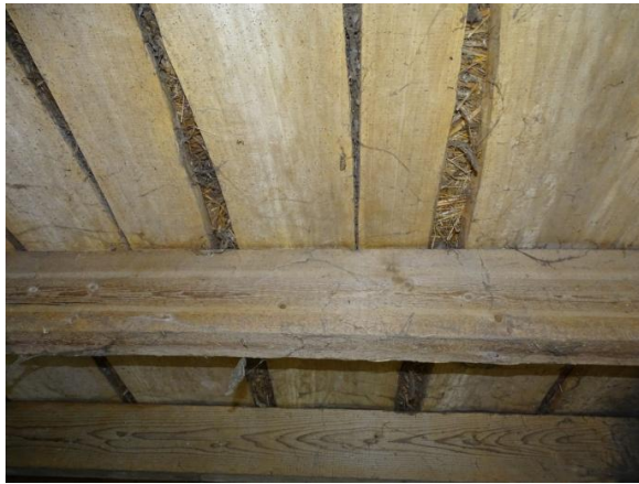
Afb. 3.100 Vloer boven ruimte C.0.12
