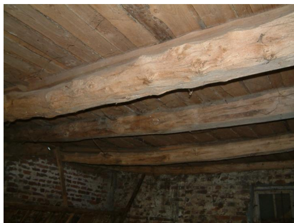
Afb. 3.102 Vloer boven ruimte C.0.14
