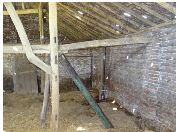
Afb. 3.137 Koppeling spant 2 met achtergevel
