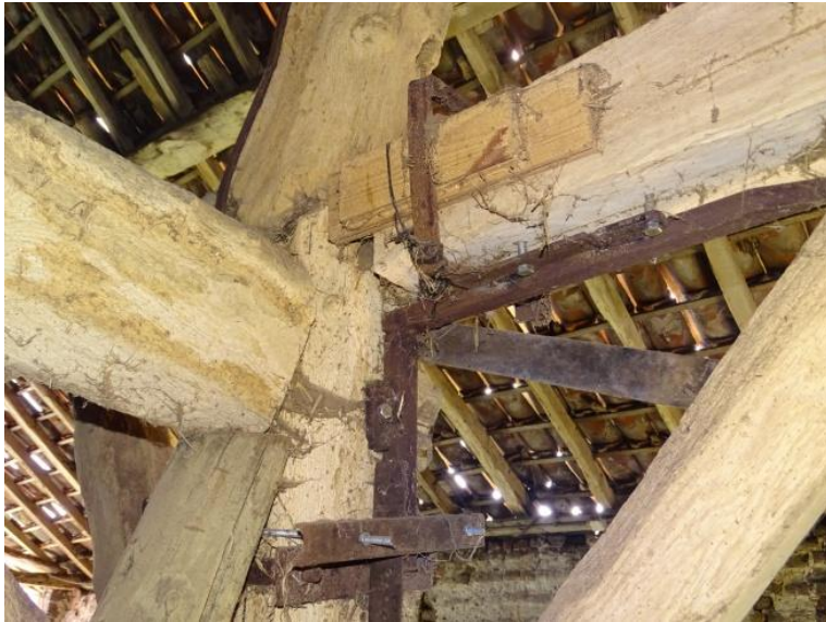
Afb. 3.119 Herstelde verbinding ankerbalkjuk
