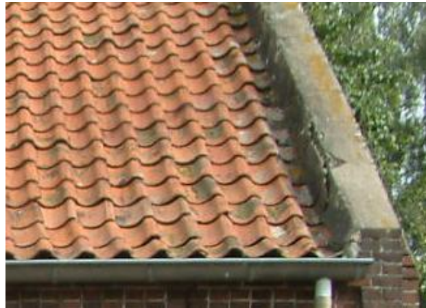
Afb. 3.14 Aansluiting dakpannen aan topgevel
