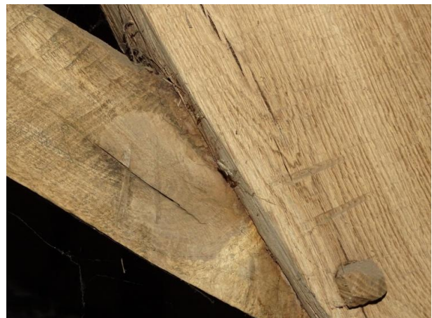
Afb. 3.109 Detail jukbalkschoor
