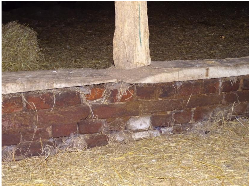
Afb. 3.117 Ondersteunconstructie vakwerk
