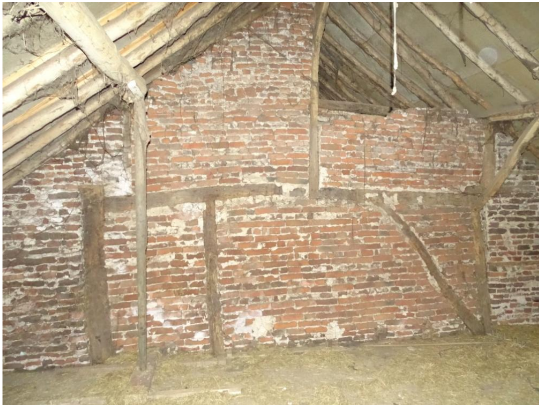
Afb. 3.110 Vakwerkconstructie tussenmuur
