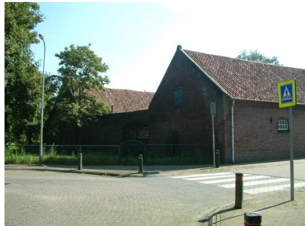
Afb. 3.16 Aanzicht zijgevel stal bouwdelen A en B
