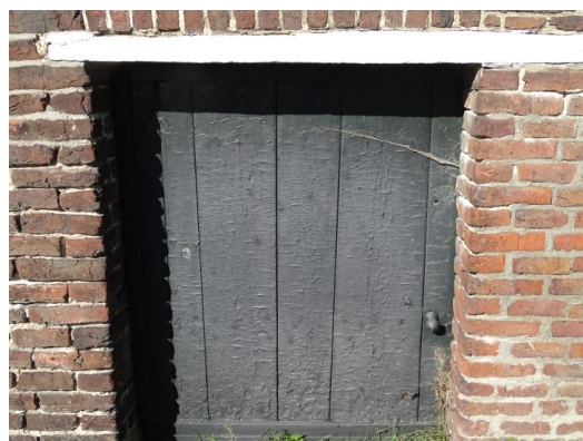
Afb. 3.46 Poort naar voormalig bakhuis
