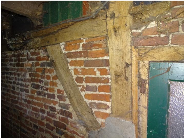
Afb. 3.198 Vakwerkconstructie in tussenmuur
