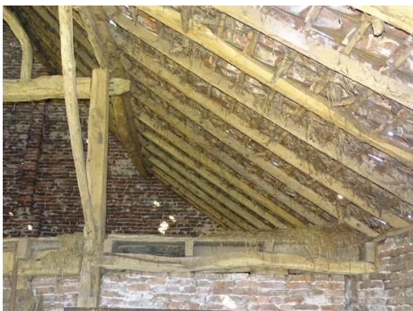
Afb. 3.136 Koppeling spant 1 met achtergevel
