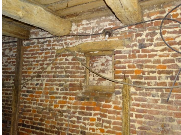
Afb. 3.206 Restanten buitenvenster in tussenmuur
