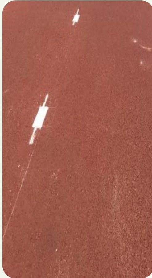
Fietspad: Asfalt kleur rood
